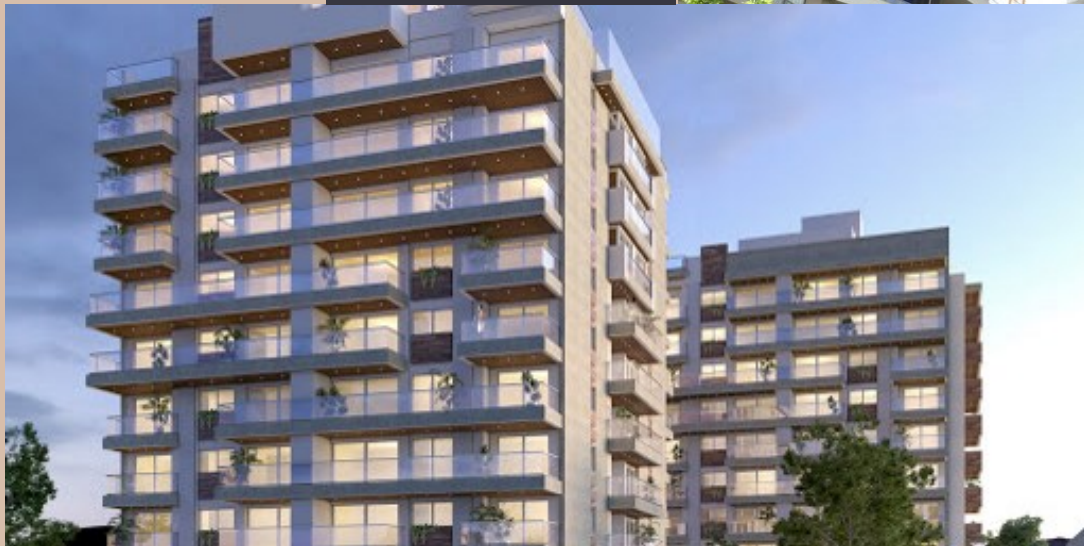
Torre Agustina— Edificio de Oficinas Irigoyen 34, Godoy Cruz
